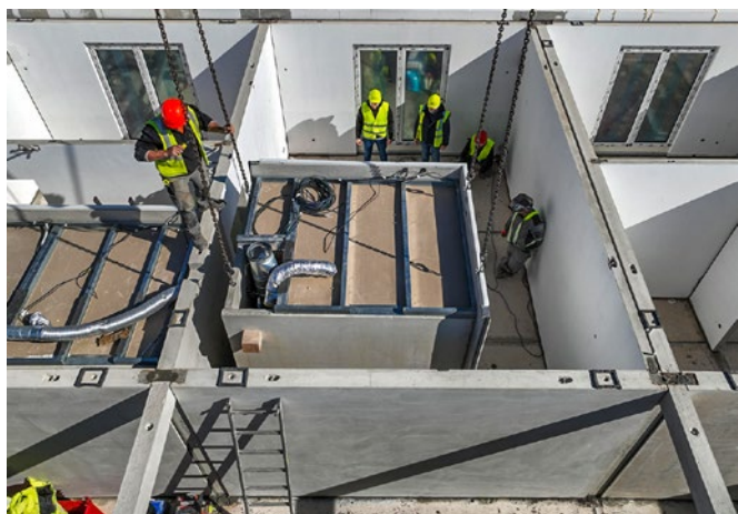
Montáž modulární koupelny z tenkostěnných železobetonových dílců do příslušného bytu montovaného bytového domu.
