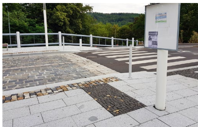
Obr. 4: Hmatové prvky sloužící k bezpečnému a samostatnému pohybu nevidomých a slabozrakých osob musí být provedeny z certifikovaného materiálu, který zajišťuje svou strukturou povrchu dostatečný hmatový kontrast. Uvedené řešení je v rozporu s nařízením vlády č. 163/2002 Sb. Zároveň signální pás nenavazuje na vodicí linie a v jeho těsné blízkosti se nachází překážka (označnick zastávky).
