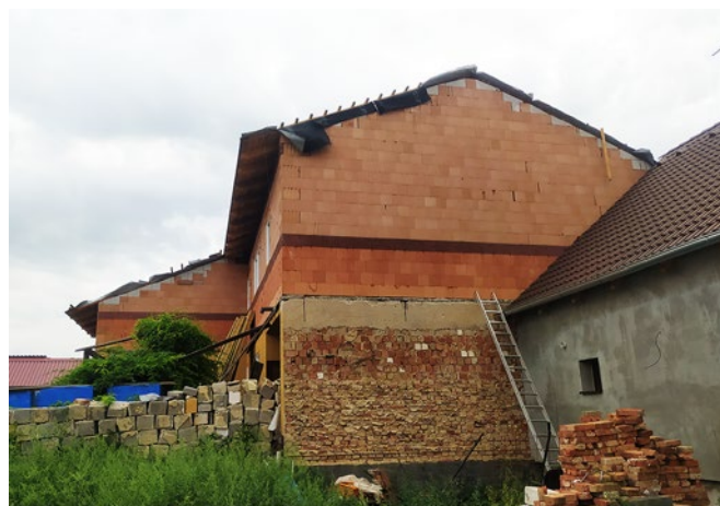
Nástavba podlaží nad původním objektem rodinného domu
