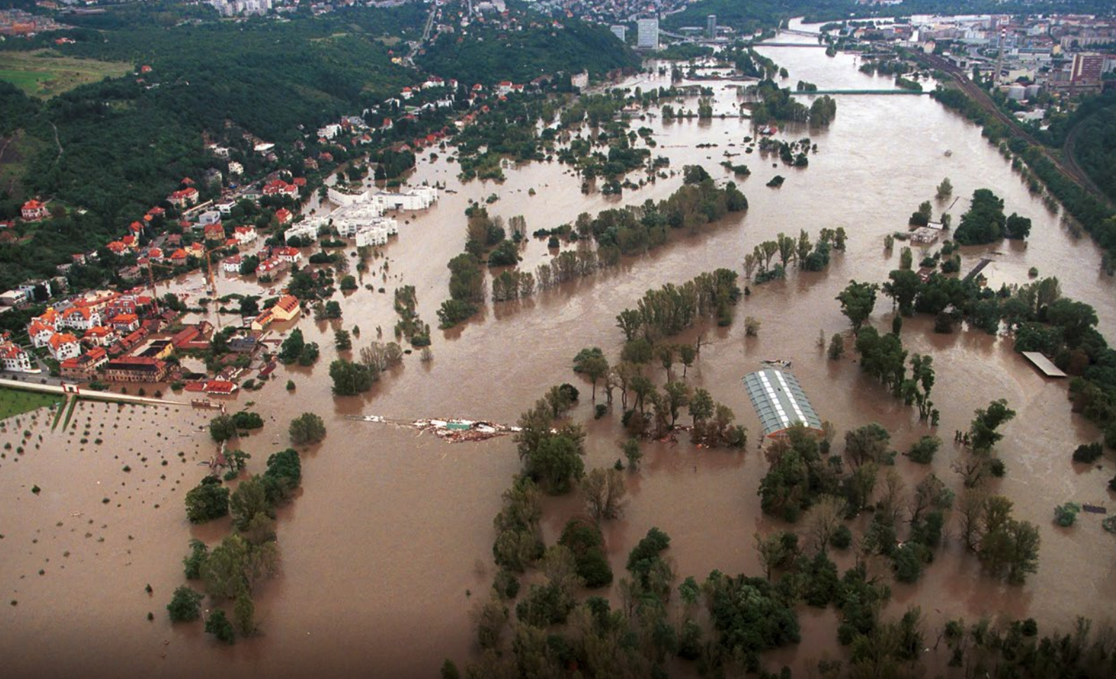
Při povodních v roce 2002 byla Trojská lávka zcela pod vodou. Ve středu lávky - v místě budoucí havárie - se zachytilo velké množství odpadů a naplavenin, které velmi pravděpodobně lávku poškodily. Foto: letecký snímek ČTK
