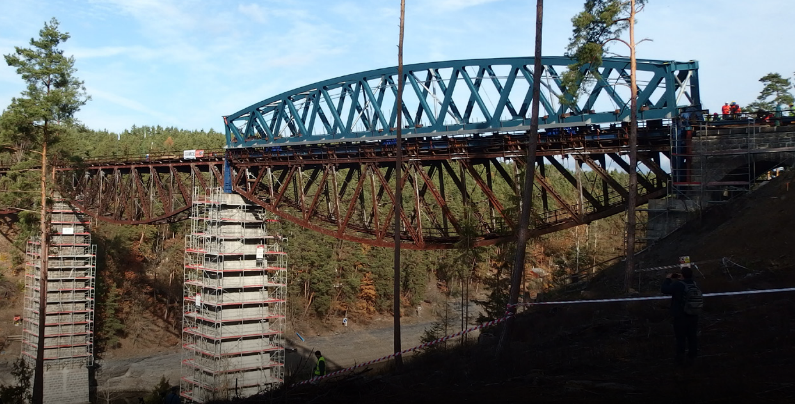
Fotografie ukazuje atypickou montáž při rekonstrukci železničního mostu Pňovany, kdy si nová konstrukce se starou vzájemně vyměnily polohy. Jednalo se o první použití postupu montáže s takovýmto otáčením konstrukcí v ČR. Video z montáže je ke zhlédnutí na zpravy.ckait.cz . (foto: Ondřej Lojík)
