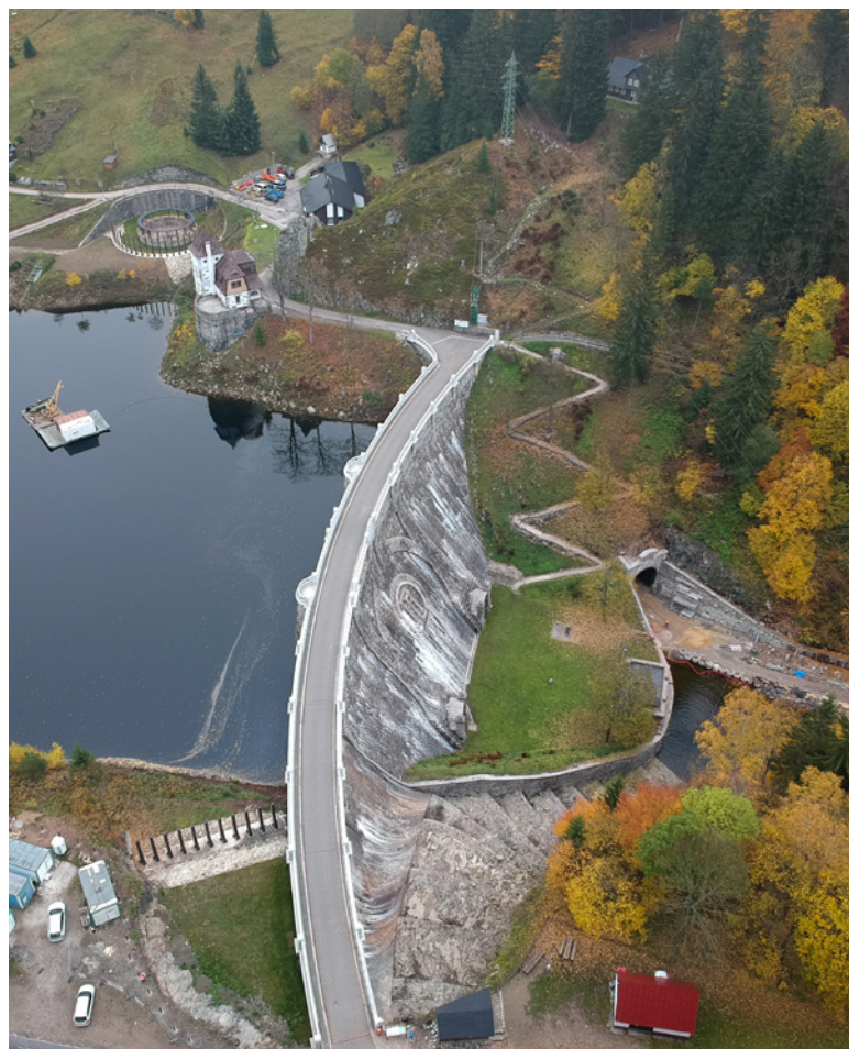
Zvýšení retenční funkce vodního díla Labská bylo dosaženo rekonstrukcí spodních výpustí v obtokovém kanálu. Instalaci ocelových nátokových trubních profilů na návodní straně obtokového tunelu provedli potápěči pod vodou v hloubce 20 m. (foto: Ing. Filip Pekárek)
