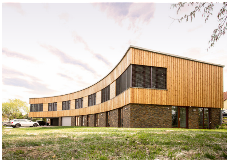
Výstavba nové administrativní budovy – LS Choceň (foto: Lesy ČR, s.p.)
