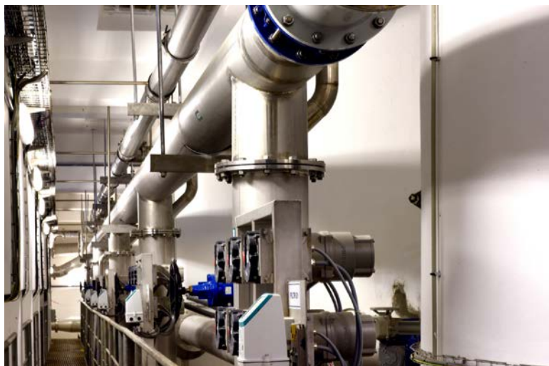
Rekonstrukce úpravy vody Tumačov – eliminace pesticidů v pitné vodě. Projektant: VODING HRANICE. Dodavatel: MEDMES, ELPREMO, POLYCONCRETE. Stavbyvedoucí: Ing. Ivan Špaček. Finanční náklady: 80 mil. Kč. Realizace: 6/2017–10/2018.
