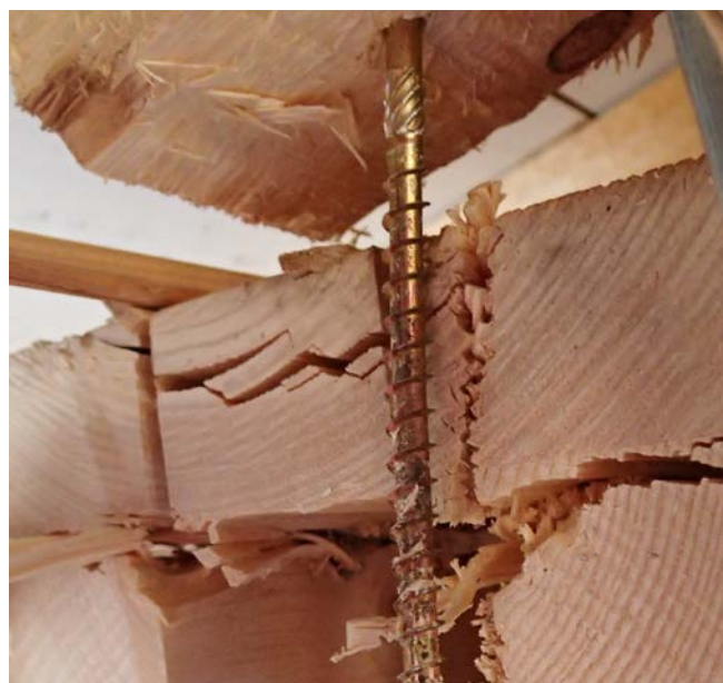
Obr. 4 Spoj vaznice a horního pasu ve styčníku (foto: Jan Chaloupský)
