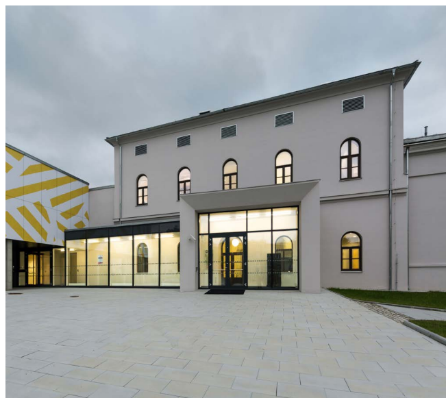
Zvláštní cena Svazu podnikatelů ve stavebnictví v ČR – Slezská univerzita v Opavě – stavební úpravy a přístavba objektu Hauerova 4 (foto: PULARY GROUP)
