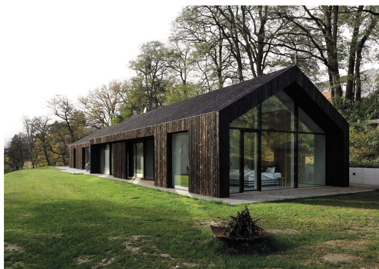
Stavba roku 2018 – Rodinný dům Neveklov (zdroj: Nadace pro rozvoj architektury a stavitelství)
