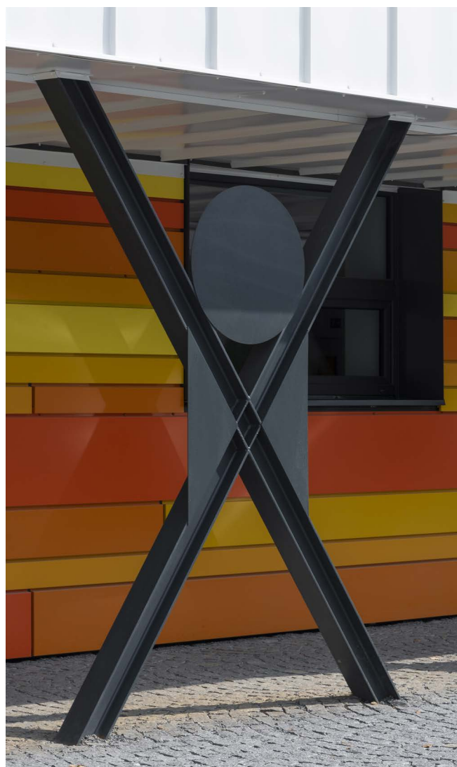
Stavba roku Středočeského kraje 2018 – Novostavba Mateřské školy Úsměv v Benešově (zdroj: Nadace pro rozvoj architektury a stavitelství)
