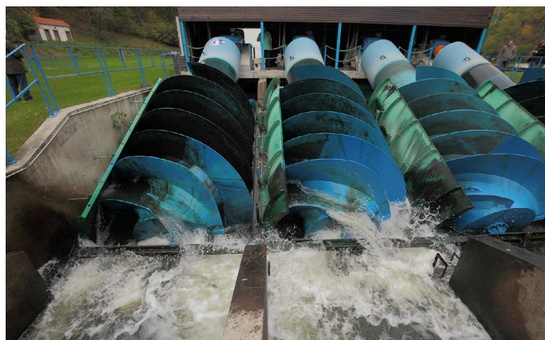
Archimédovy šrouby v chodu si na exkurzi Malé vodní elektrárny 5. října 2017 prohlédlo 22 účastníků. (foto: Ing. Václav Mužík)
