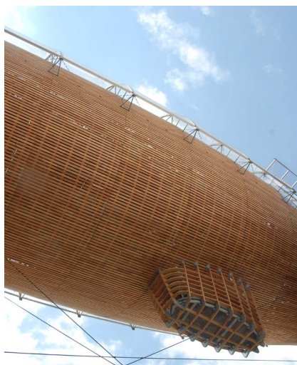
Modřínová dřevěná konstrukce vzducholodi Gulliver
