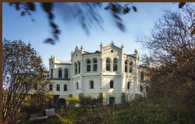
Jízdárna ve Světcích byla oceněna titulem Stavba roku Plzeňského kraje v kategorii Rekonstrukce budov (na titulní straně)
