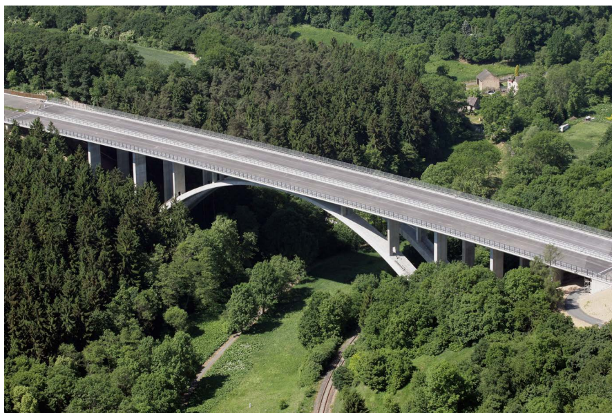
Cenu ČKAIT pro projektanta získal Ing. Milan Kalný, projektant jednoho z největších obloukových železobetonových mostů v ČR, jenž přechází přírodní rezervaci Opárenské údolí, do kterého během stavby nesměla vkročit noha zhotovitele. Unikátní konstrukce ve směrovém i výškovém oblouku.
