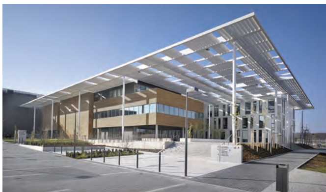
Budovu Mezinárodního výzkumného centra ELI v Dolních Břežanech stíní bílá konstrukce z oceli a hliníku . . . . . 28
