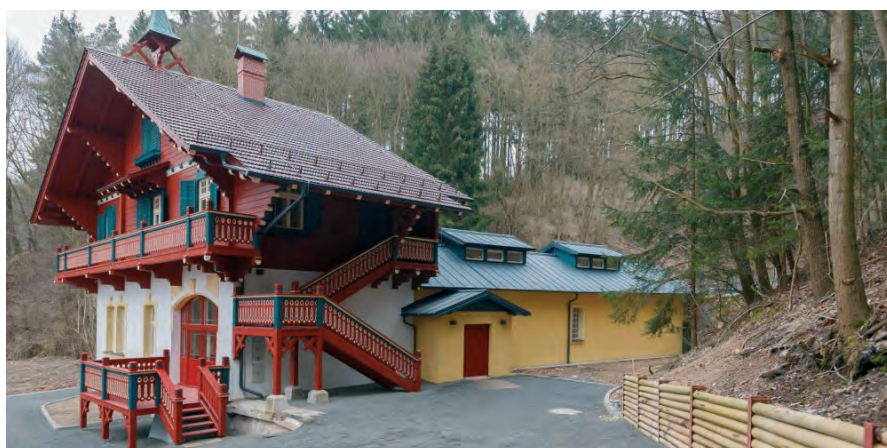
Muzeum Mattoni v Kyselce (bývalá stáčírna Löschnerova pramene). Budova nese jméno po lékaři Dr. Josefu Löschnerovi, příteli Heinricha Mattoniho. Stavba byla uvedena do provozu v červenci 2016. Zhotovitel: firma BOLID – M s.r.o., projektant: společnost MEDIKA Karlovy Vary s.r.o., specialista na umělecko-řemeslné prvky: Michal Konáš.
