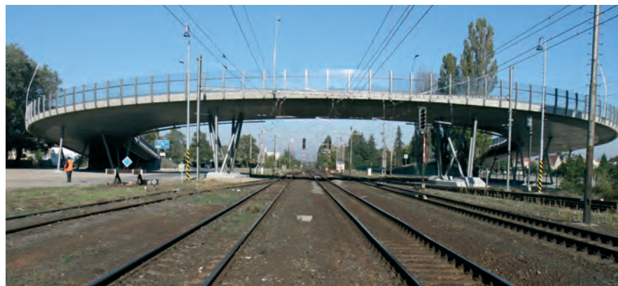
III/329 Poděbrady – přemostění trati Českých drah (foto: archiv Pontex, spol. s r.o.)
