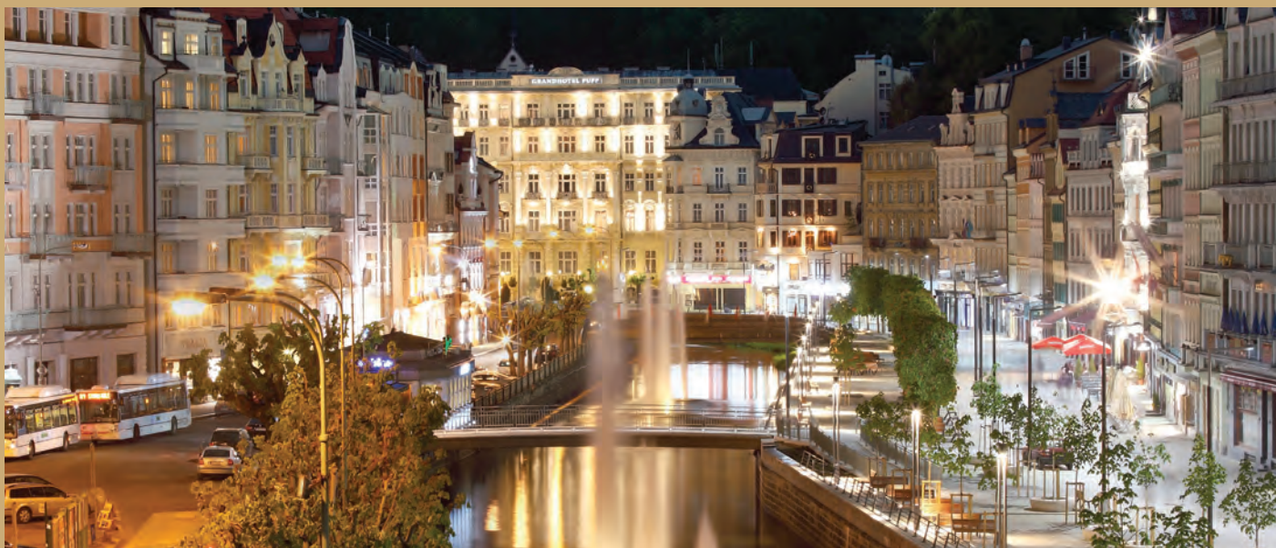
Zrekonstruovaná promenáda na levém břehu řeky Teplé, Stará Louka, Karlovy Vary. Generální projektant: INDUSTRIAPLAN s.r.o., zhotovitel stavby: STRABAG, a.s., stavbyvedoucí: Lukáš Jára, realizace stavby: 10/2009–04/2011.
