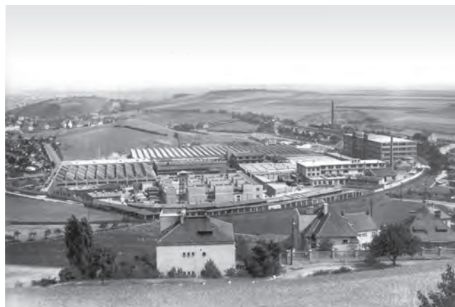
Areál firmy Walter v roce 1943. Foto z archivu společnosti Walter, a.s.
