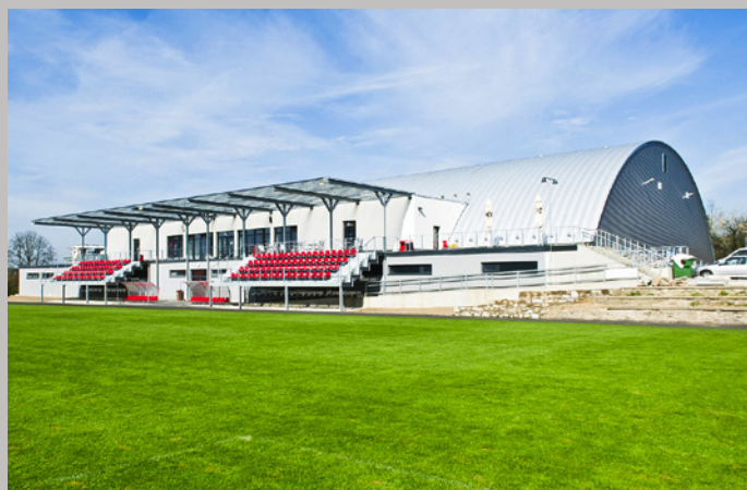
Zimní stadion Telč, čestné uznání Stavba roku Kraje Vysočina 2015
