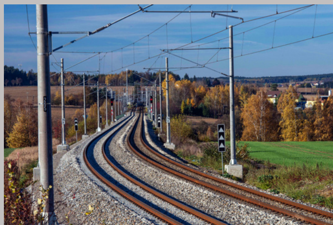
Rekonstrukce koleje č. 1 a 2 Sklené nad Oslavou – Ostrov nad Oslavou, čestné uznání Stavba roku Kraje Vysočina 2015
