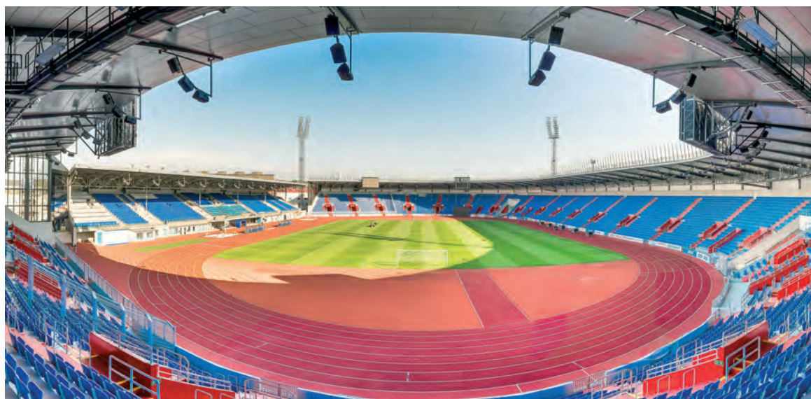
Rekonstrukce Městského stadionu v Ostravě – Vítkovicích
