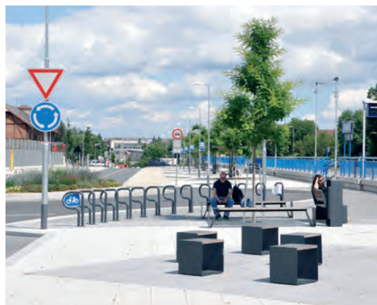
Stavba roku Kraje Vysočina 2015: Přestupní terminál Třebíč
