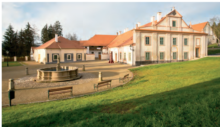
Centrum stavitelského dědictví v Plasích – památková obnova hospodářského dvora
