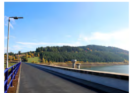
• VD Karolinka – rekonstrukce hráze
