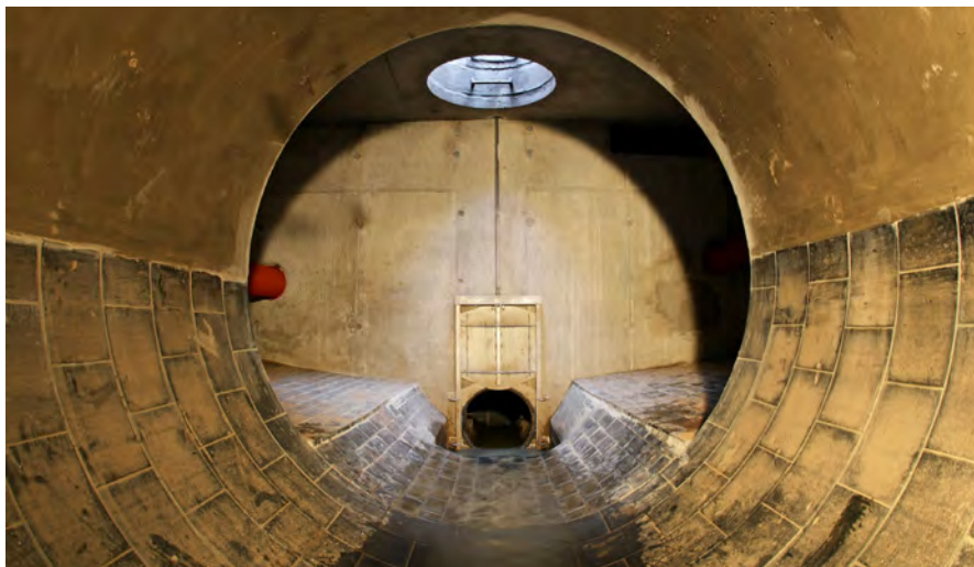
Retenční stoka DN 2200 v ulici Dvorská, Hradec Králové
