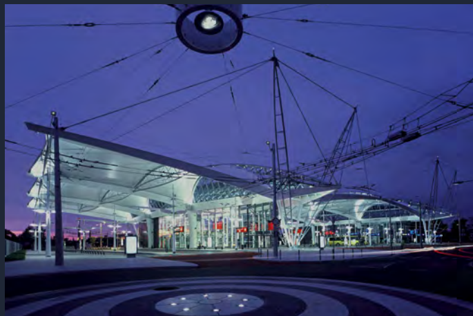
Terminál hromadné dopravy v Hradci Králové – titul Stavba roku v soutěži Stavba roku Královéhradeckého kraje 2009
