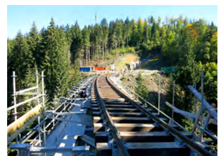
• Rekonstrukce Harrachovského tunelu
