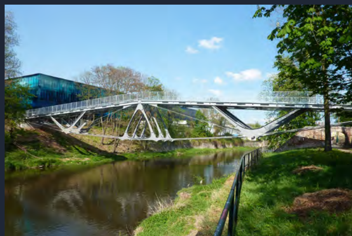
Lávka pro pěší a cyklisty přes Orlici u zimního stadionu – titul Stavba roku v soutěži Stavba roku Královéhradeckého kraje 2013
