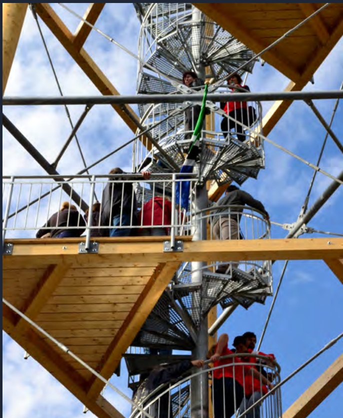
Rozhledna na kopci Milíř ve Vysoké nad Labem – Čestné uznání v soutěži Stavba roku Královéhradeckého kraje 2014
