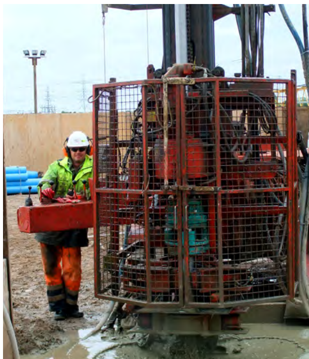
Na stavbě ve Velké Británii – vystrojení vrtné soupravy pro tryskovou injektáž ochrannými kryty a ochrannými bezpečnostními systémy podle nové normy
