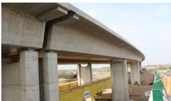
Okružní křižovatka u Opatovic nad Labem těsně před dokončením. . . . . 33
