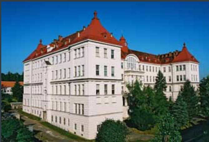
Opravená budova Z v areálu FAST VUT
