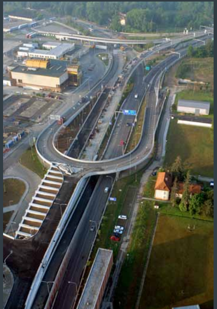
Mimoúrovňová křižovatka Hlinky/Pisárská – součást VMO Brno
