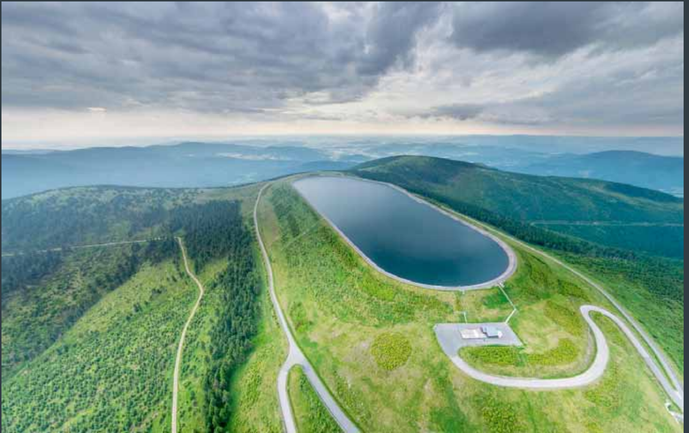
PVE Dlouhé Stráně – horní nádrž (2015) – vodní dílo bylo projektováno v Brně (foto: archiv AQUATIS, a.s.)
