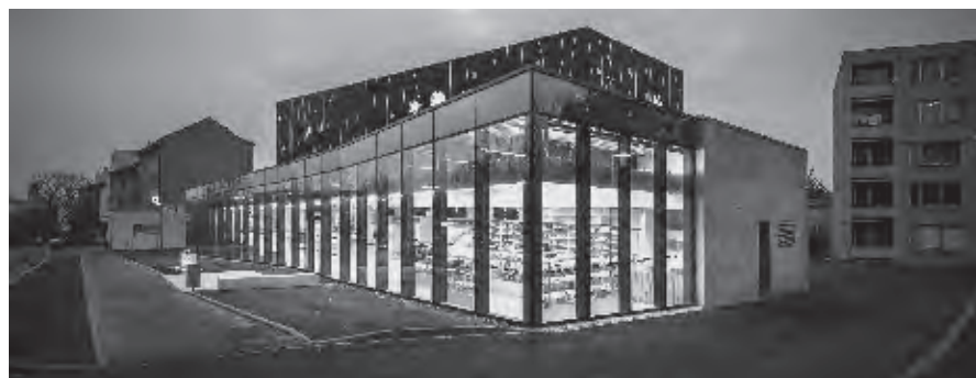
Novostavba lékárny Fakultní nemocnice Olomouc
