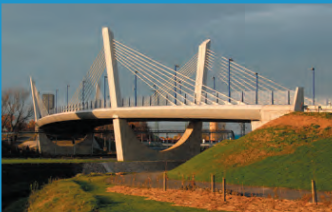
Most na silnici I/67 Skřečoch – Bohumín
