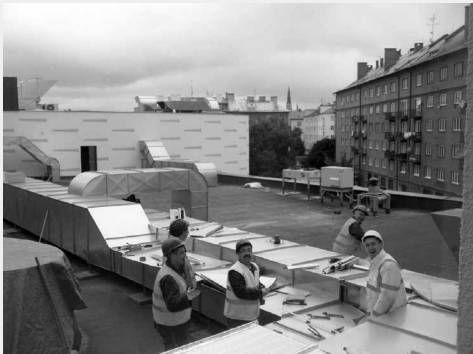
Technologická montáž na navštívených stavbách
