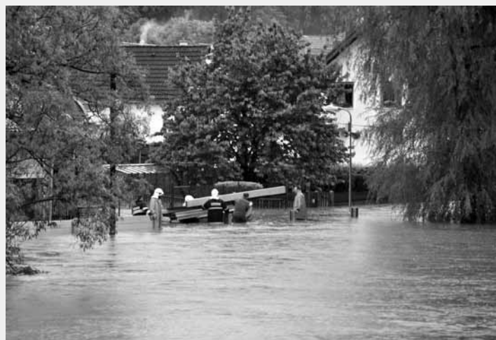
Lužnice – Bechyně – montované stěny nebylo možno dokončit před rychlým nástupem první povodňové vlny
