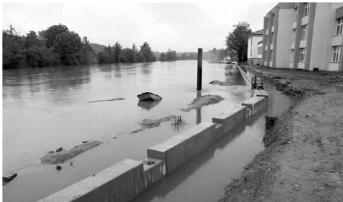
Planá nad Lužnicí – nedokončená ochranná stěna
