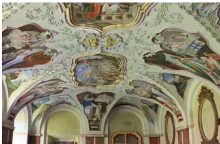
Část budoucí nádhery interiérů před dokončením rekonstrukce
