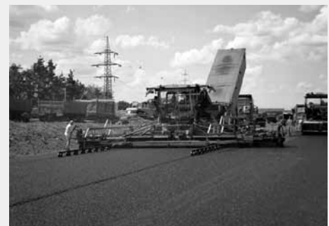
Výstavba dálnice D3 v úseku Tábor – Veselí nad Lužnicí
