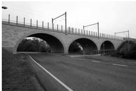
Železniční most km 86,021 na trati Praha – Smíchov – Plzeň
