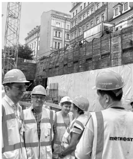
Na staveništi administrativního centra Quadrio v Praze
