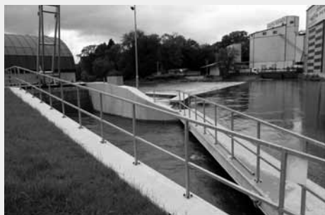
Malá vodní elektrárna ve Svijanech – exteriér (foto: Ing. Stanislav Gajzler, Ing. Karel Zikmund)
