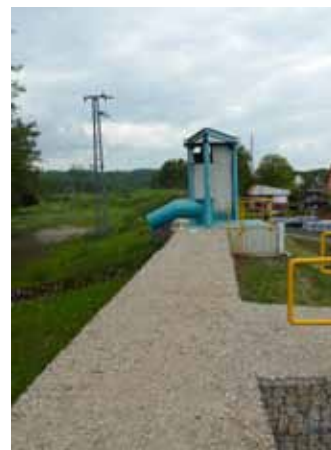
Královské Poříčí – povodňová ochrana, čerpací stanice integrovaná do hrází
