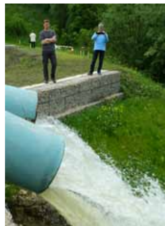
Královské Poříčí – povodňová ochrana, čerpací stanice integrovaná do hrází
