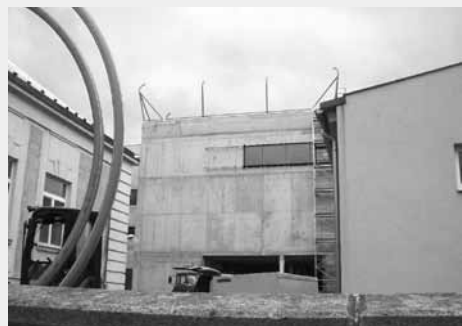
Dostavba Slovanského gymnázia v Olomouci
