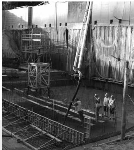
Malá vodní elektrárna Roudnice – stavební jáma
