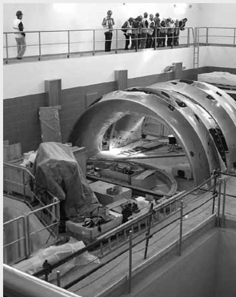
Vodní dílo Litoměřice – České Kopisty – „malá“ turbína má průměr oběžného kola 5100 mm
