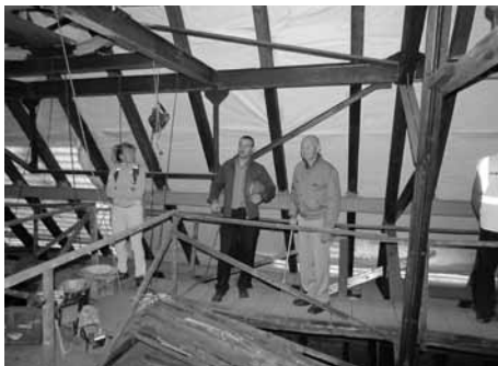
Původní ocelový krov kostela svatě Máří Magdaleny
