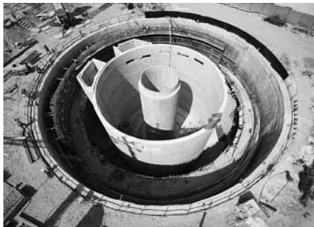
Retenční nádrž s tangenciálním nátokem na soutoku Svatky a Svitavského náhonu v Komárově na Jeneweinově ulici má průměr 32 m a hloubku 20 m
