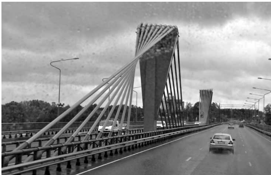
Konstrukčně zajímavý zavěšený most na výjezdní komunikaci z Rigy do Litvy
