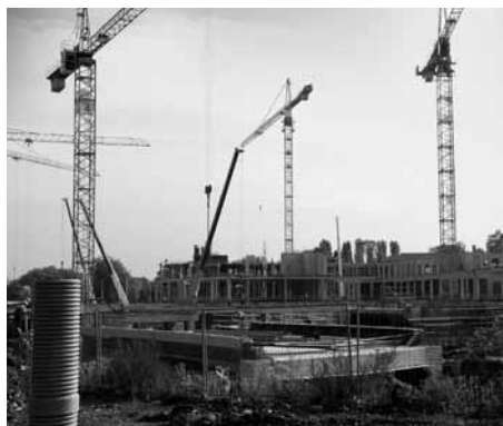
Galerie Šantovka – obchodní a společenské centrum ve výstavbě
