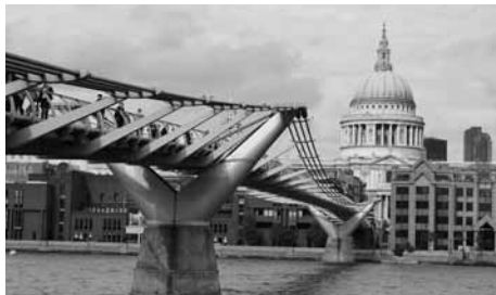
Londýn – Millenium Bridge
