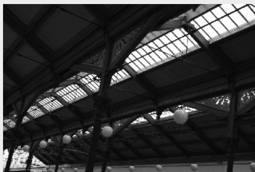
Železniční muzeum v Praze – detail střechy
