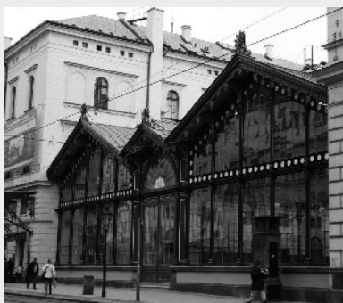
Železniční muzeum v Praze – pohled zevně
