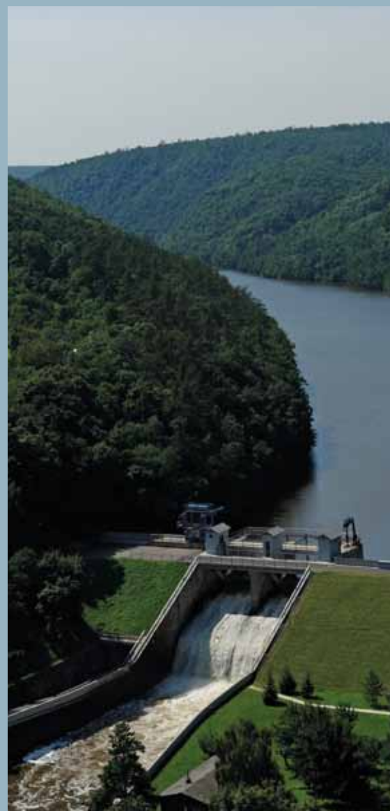
Vodárenská údolní nádrž na řece Dyji ve Znojmě
