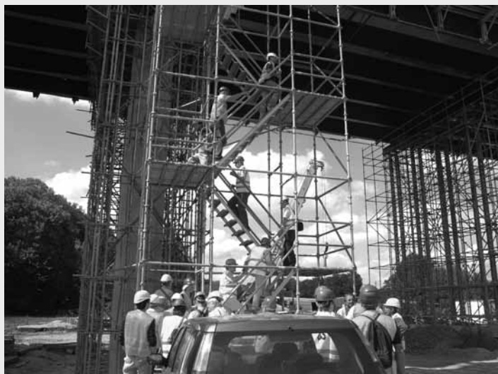
Účastníci exkurze na stavbě mostu ve Vamberku
