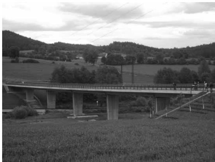
Pohled na most přes železniční trať a Živný potok
