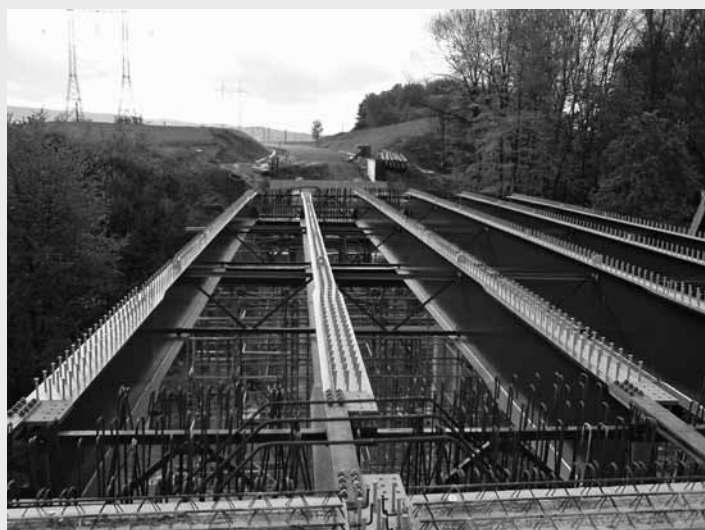
Pohled na montáž výztuže spřažené ocelobetonové roštové konstrukce mostu
