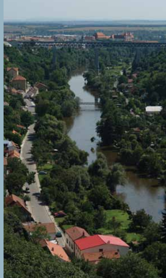
Železniční most přes údolí Dyje ve Znojmě obdržel čestné uznání v soutěži o Cenu ČKAIT 2010
