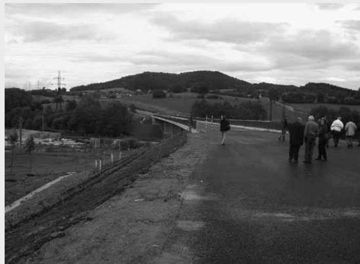
Pohled na stavbu silnice Hostinec–Běleč
