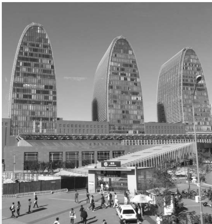
Administrativní komplex se stanicí metra tzv. „Okurky“
