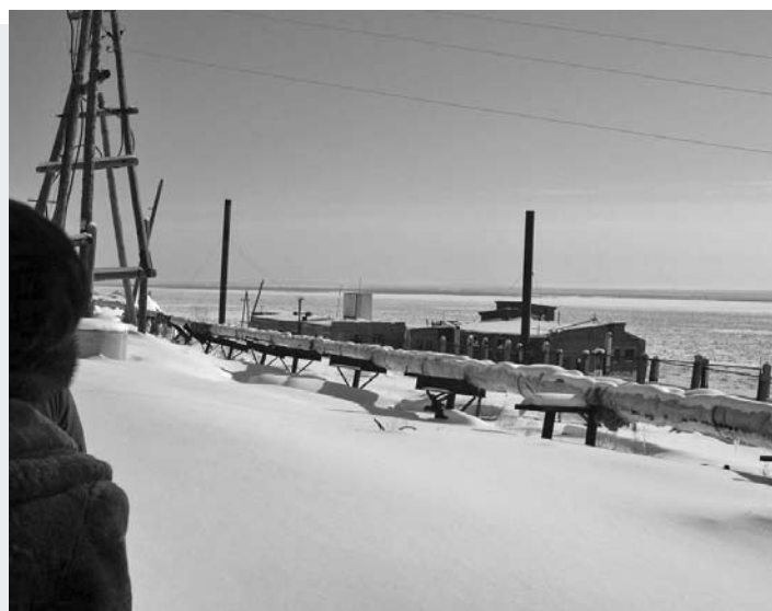
Inženýrské sítě jsou vedeny po povrchu a izolovány
