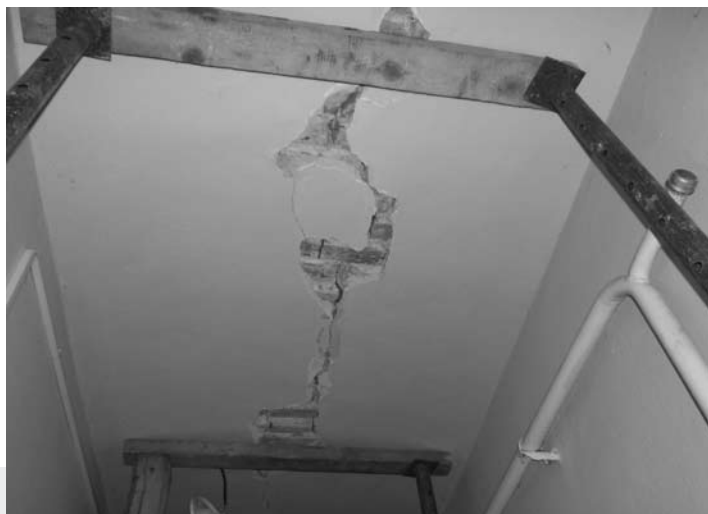
Obr. 3 Detail podepření klenby v chodbě přízemního domu
