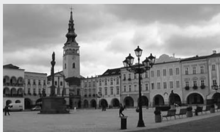
Náměstí v Novém Jičíně – po rekonstrukci
