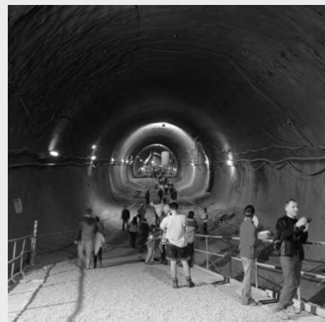
Den otevřených dveří na stavbě Královopolských tunelů – rovněž viz foto na titulní straně
