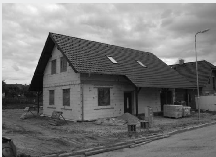
Obr. 4 Pohled na hrubou stavbu rodinného domu ze zdiva YTONG
