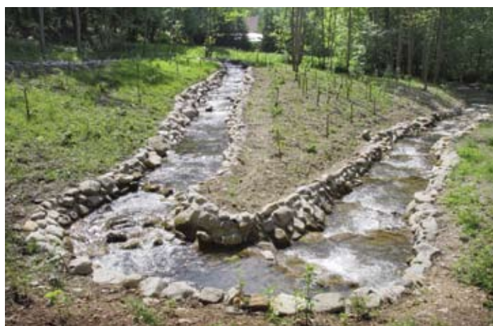
Přechod pro ryby vybudovaný v rámci stavby Odbahnění rybníka v Prkenném dole
