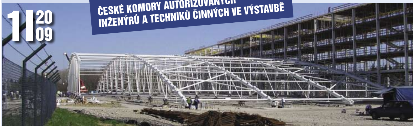
Nosná ocelová konstrukce hangáru Mošnov, Ing. Vladimír Janata, CSc., EXCON, a.s. Praha
