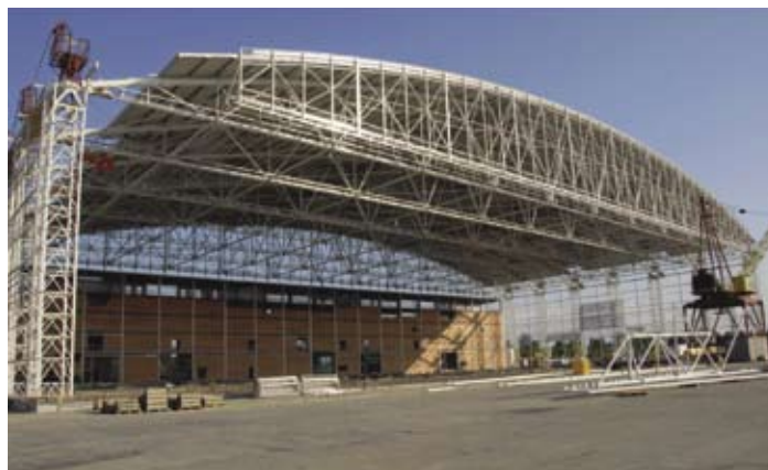
Zvedání vazníků střešní konstrukce hangáru Mošnov
