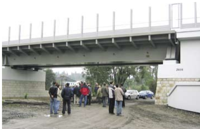
Mosty u Jablunkova – Bystřice nad Olší, foto: Ing. Miloš Kolouch
