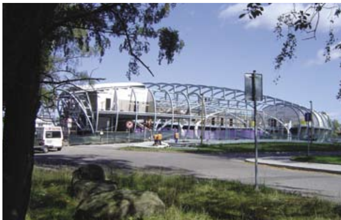
Celkový pohled na strukturu nosné konstrukce haly odbavovacího terminálu
