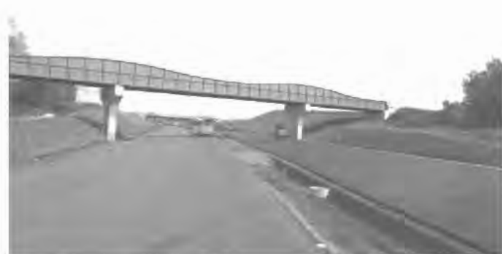
Lávka nad dálnicí D8 mezi Ústím nad Labem a státní hranicí
