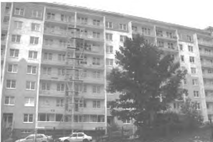
Opravu lodžii BD Mácha – Most, blok 576, provedla firma TEPO v květnu až srpnu roku 2005
