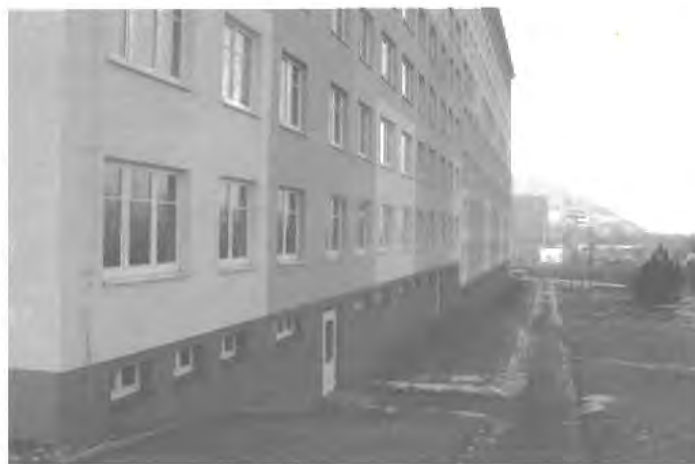
Blok 576 – stav vnějších fasád (leden 2006)
