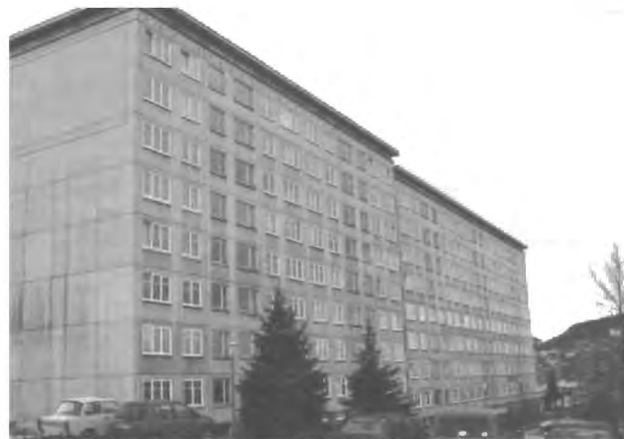
Blok 576, zadní průčelí (2003) po výměně oken (bytové jednotky) a rekonstrukci střechy
