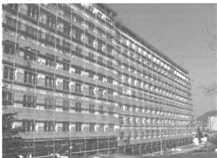
Zateplení obvodového pláště bloku 576 prováděla v květnu 2004 firma TEPO Litvínov – kontaktní zateplovací systém ALSECCO
