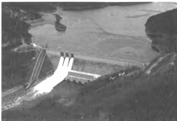
Přehrada Orlik na Vltavě dne 30. 3. 2006. Průtok přes přeliv 200 m 3 /sec. Regulovaný kulminační přepad mezi dny 4. 4. 2006 a 6. 4. 2006 byl 400 m 3 /sec
