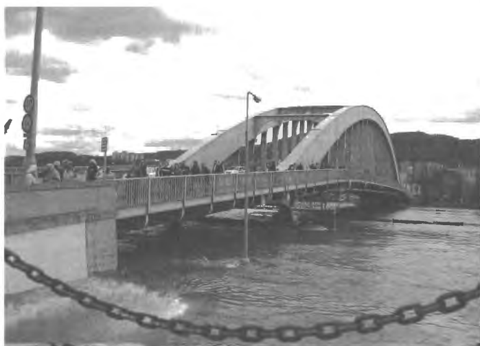
Povodeň na Labi v Ústí nad Labem. Vzduť pod Benešovým mostem před kulminací průtoku
