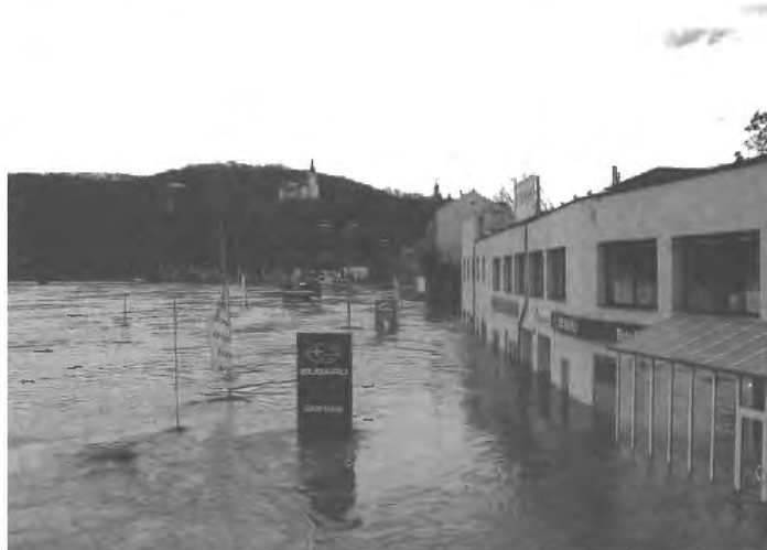
Povodeň na Labi v Ústí nad Labem. Levobřežní silnice mezi Benešovým a Železničním mostem
