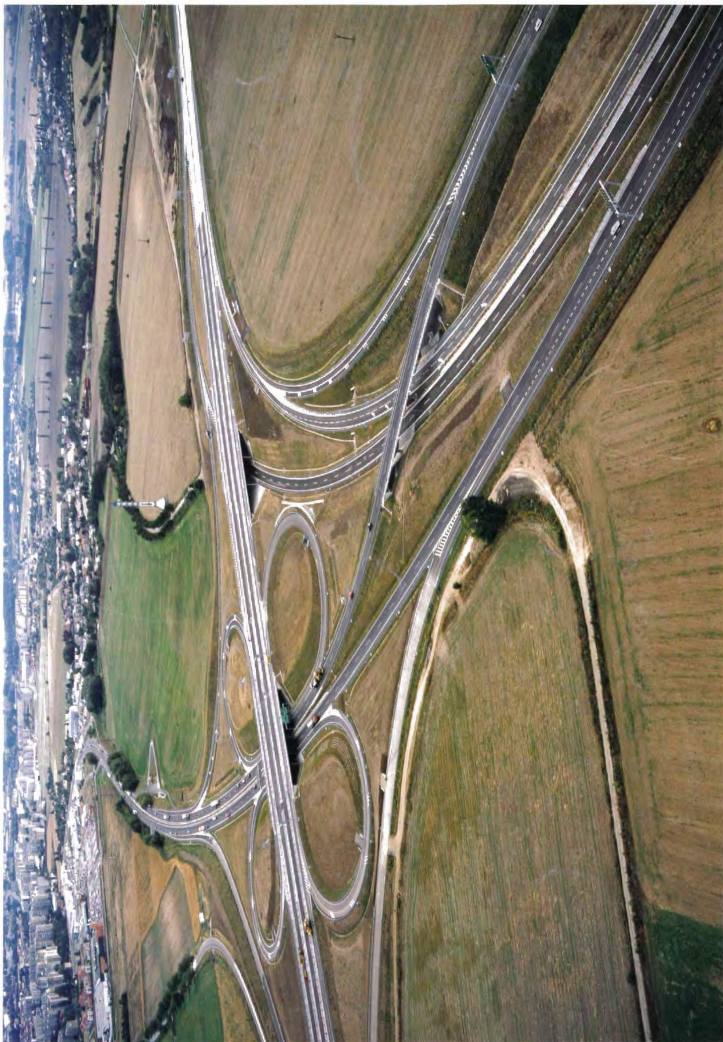
Rychlostní silnice R35 Slavonín–Přáslovice. Autor projektu: SHB, a.s. Investor: Ředitelství silnic a dálnic ČR. Dodavatel: Skanska DS, a.s. Stavba roku 2004 Olomouckého kraje
