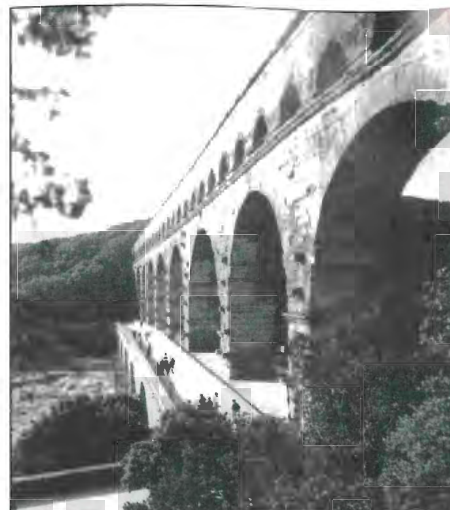
Most Pont du Gard v jižní Francii z 2. st. př. n. l. je součástí akvaduktu o délce 50 km a průměrném spádu 0,12 promile
