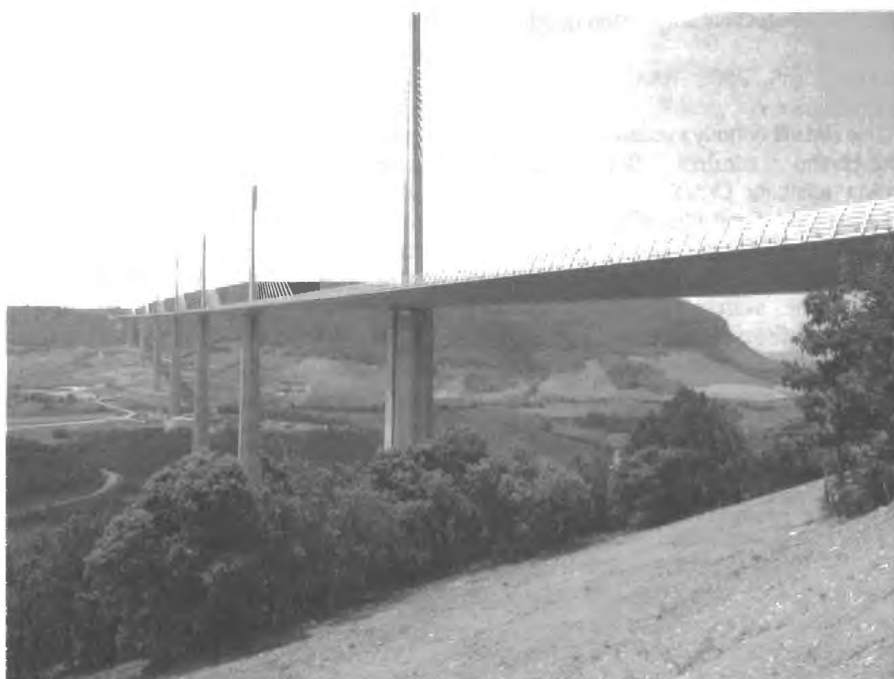
Viaduktem je překlenuto údolí řeky Tarn u Millau, úspora času na trase Paříž–Barcelona je proti původní dopravě údolím minimálně 2 hodiny
