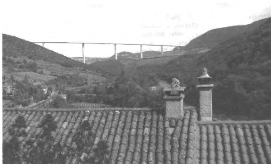
Pohled na viadukt přes střechy nádherné středověké vesnice Peyre
