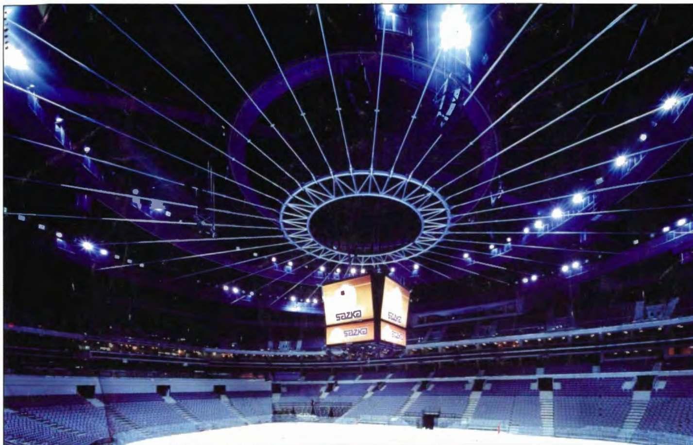
Sazka Aréna. Ocelová konstrukce zastřešení. Projekt autora Ing. Vladimíra Janoty, CSc., byl oceněn cenou ČKAIT 2004
