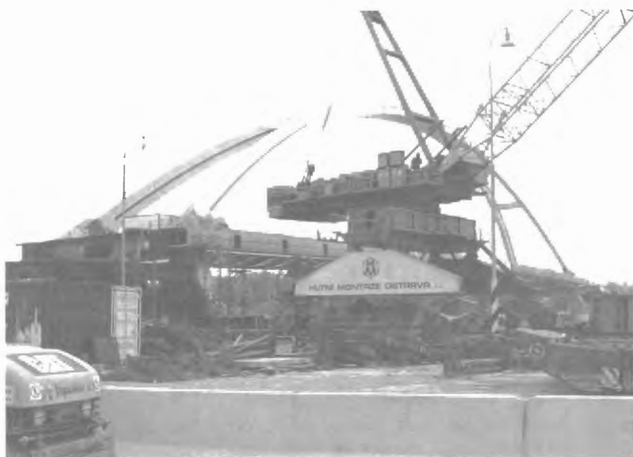
Most přes Dunaj v prodloužení ulice Košické v Bratislavě - stav týden po dokončení otáčení a osazení na provazeřní pilíř.
