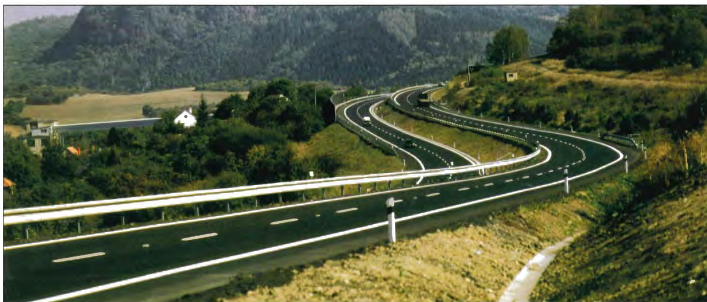
Silnice I.13 Most - Bílina - zkapacitnění
