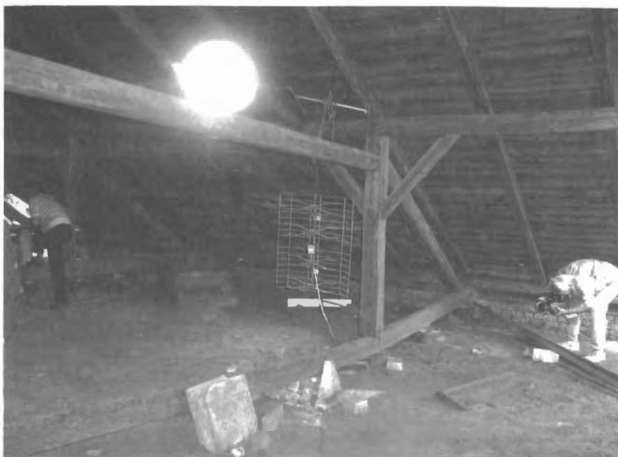
Střecha byla nadzvednuta a při zpětném dopadu byly zlomeny některé části vazby.
