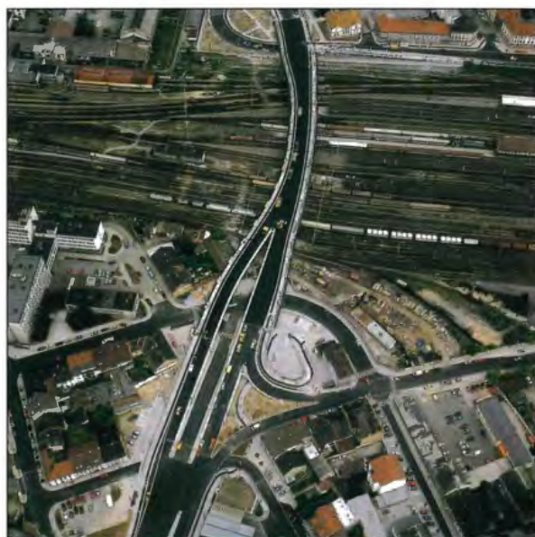
Plzeň Lobežská ul. - přemostění nádraží
