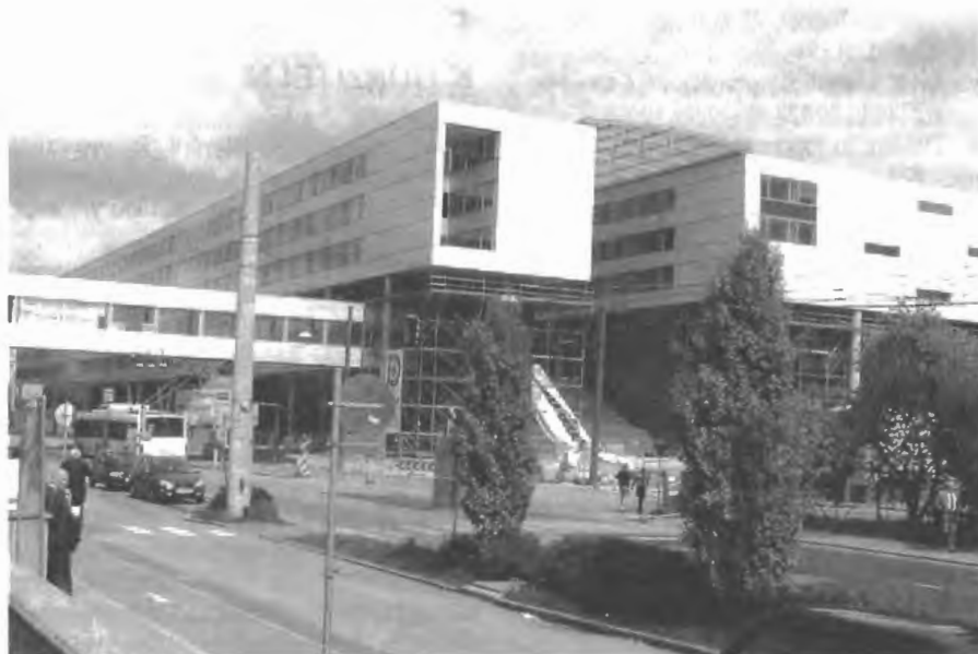
Novostavba budovy zemské vlády Horního Rakouska před dokončením
