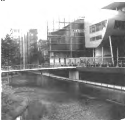
Část pláště budovy montážního závodu VW v Drážďanech
