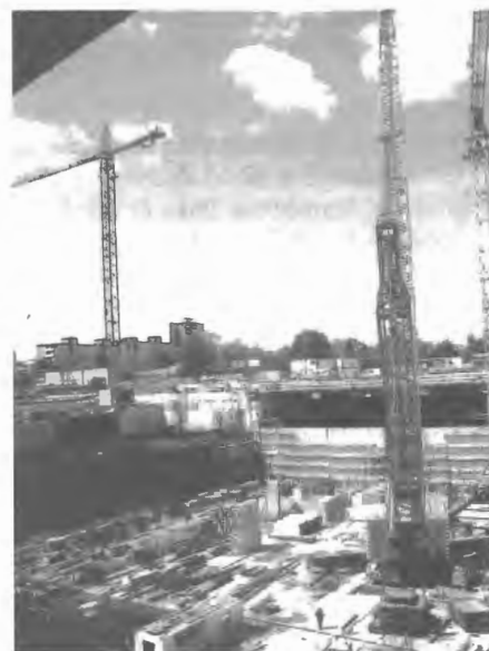
V části nádraží Lehrter Bahnhof jezdí vlaky S-Bahn a v hlavní jímce pro komunikace a služby se pracuje
