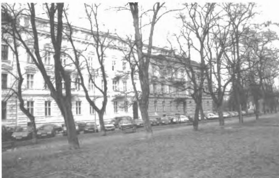
Budova ČKAIT v Brně Vrchlického sad 2
