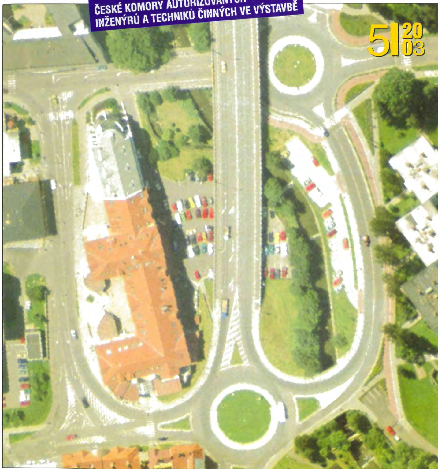
Průtah Vsetínem - soubor staveb na silnicích č. III/05735, III/05737 a místní komunikaci ul. Nádražní
