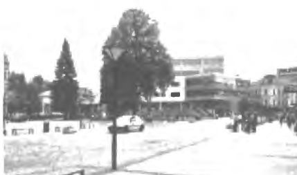
Rekonstrukce - stavební úpravy Dolního náměstí Vsetín
