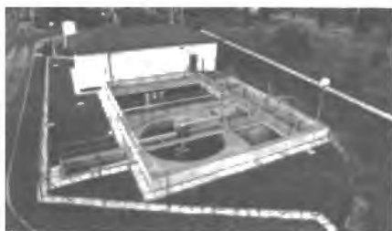
ČOV a kanalizace Babice
