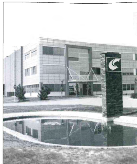
Logistické centrum JIPOCAR Jihlava. Prestižní stavba Vysočiny 1992 – 2002.
