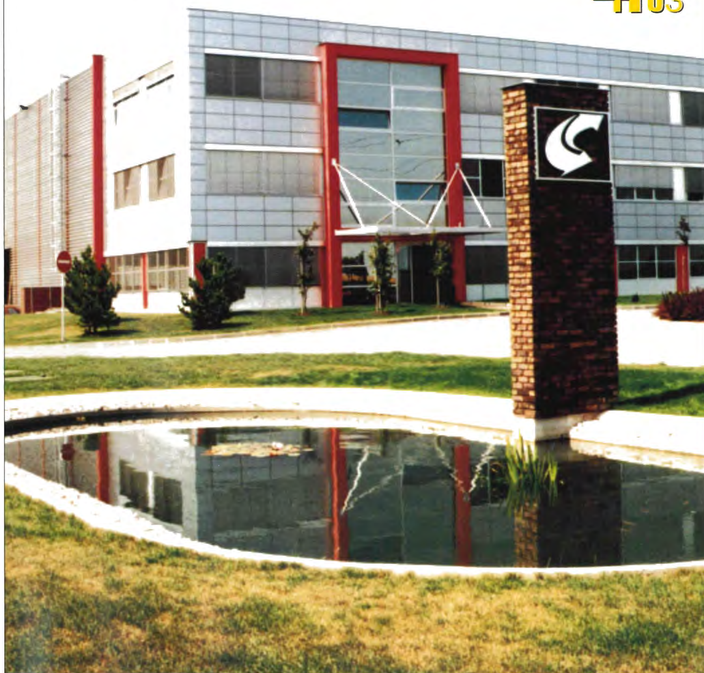
Logistické centrum JIPOCAR Jihlava. Prestižní stavba Vysočiny 1992 – 2002.
