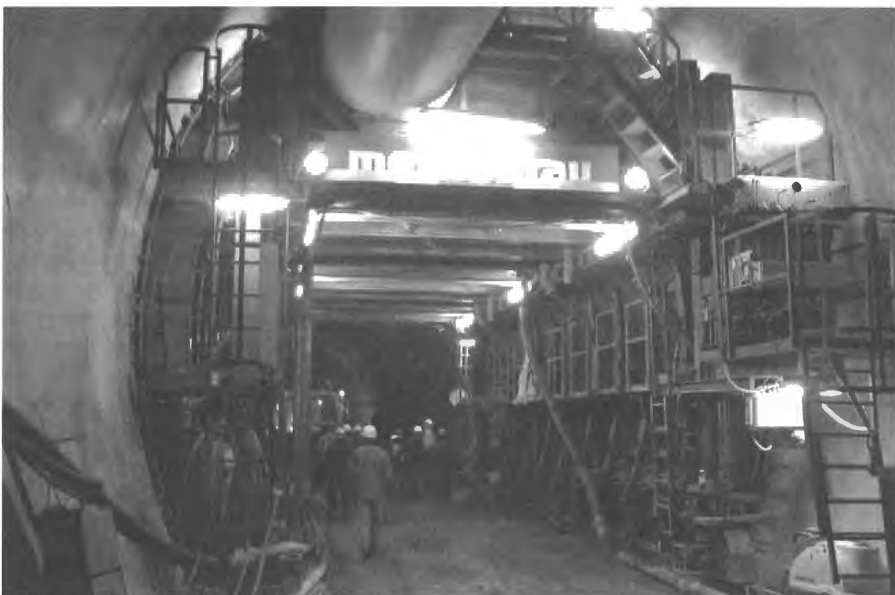
Exkurze v tunelu u Chomutova, pohled na portál razicího stroje.
