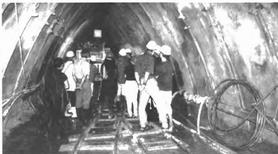
Prohlídka výztuže ražebního postupu a geotechnického sledování
