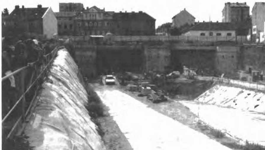
Pohled na portály průzkumných štol a místo portálů budoucích tunelů
