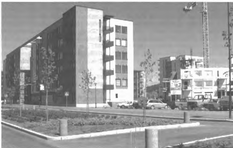
Nová výstavba bytových domů v Jyväskylä ve Finsku
