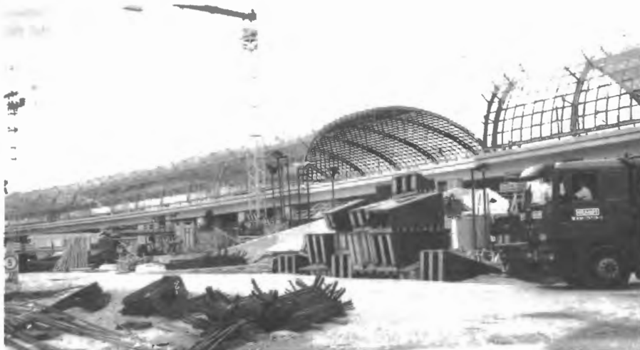
Zasklená střecha na nástupišti ve výstavbě
