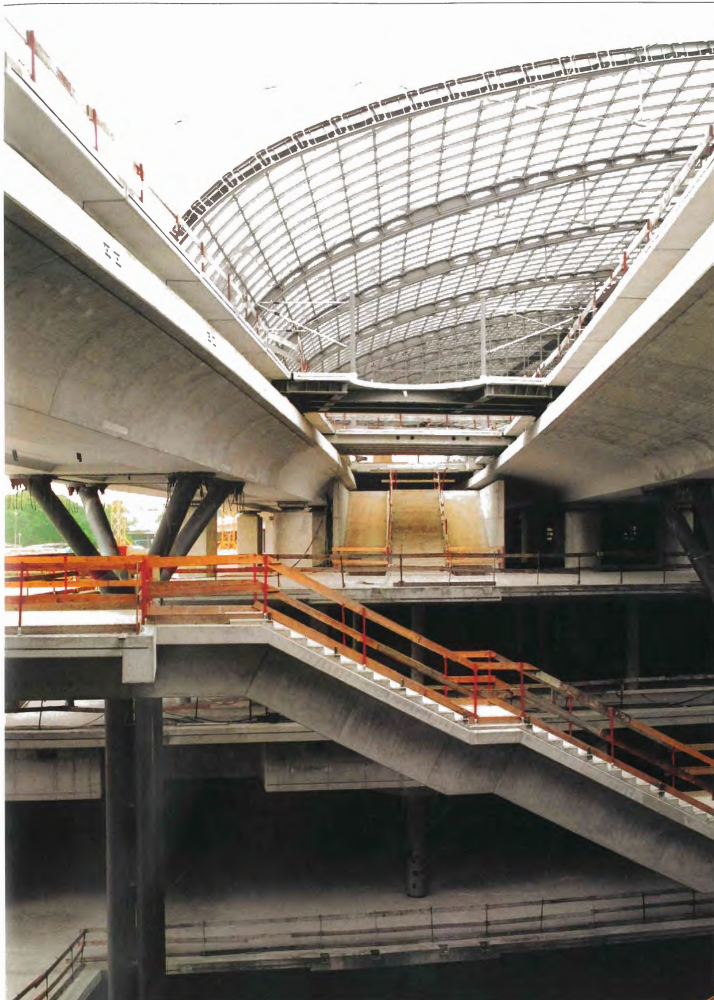
Stavba centrálního nádraží Lehrter Bahnhof v Berlíně, stav červen 2002. Dokončení stavby: 2005
