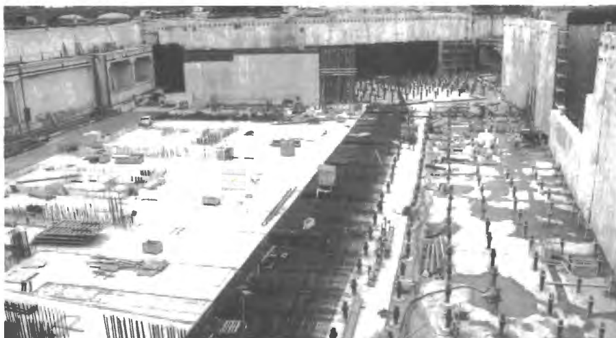
Pohled do jedné z kotvených stavebních jámečků. V pozadí ústí tunely S Bahn a U Bahn
