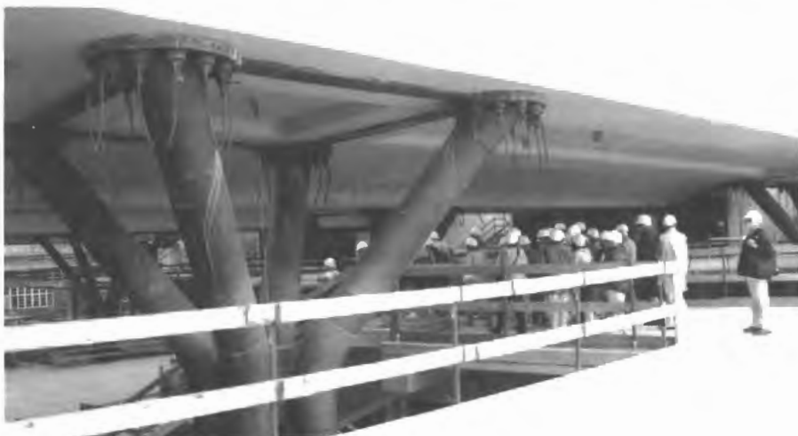
Detail vidlicového zhlaví svislého ocelového sloupu
