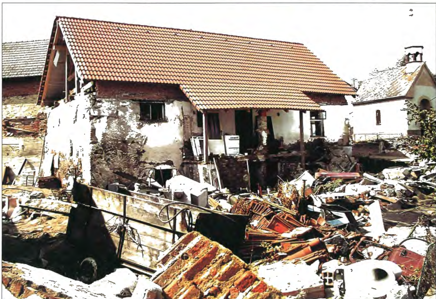
Obec Metly v okrese Strakonice poškozená v povodních, srpen 2002.
