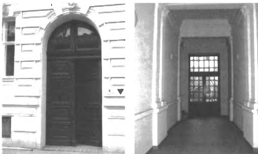
Vstupní dveře do domu ČKAIT v Brně. Vstupní chodba s pohledem do dvora. Stěny byly sanovány speciální technologií proti vlhkosti.
