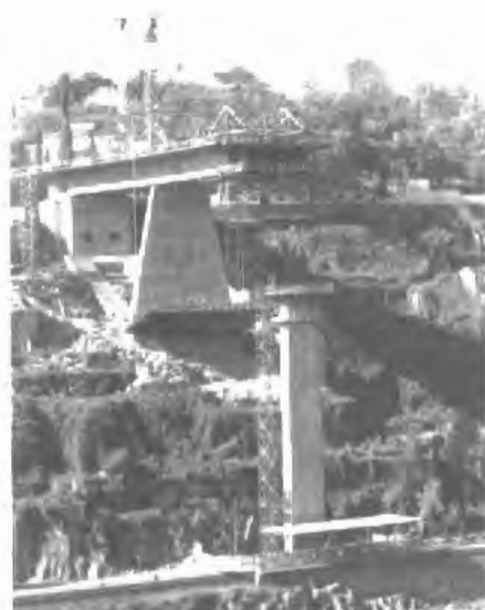
Výstavba železobetonového obloukového mostu přes řeku Douro
