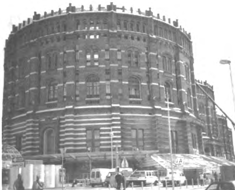
Pohled na čtyři plynovny z minulého století. Původní zdivo vnějšího pláště je památkově chráněno. Do zdiva bylo proražena další okna podle pokynů památkového úřadu, aby byl vnitřní prostor více prosvětlen. Průměr cca 37 m, výška cca 70 m.
