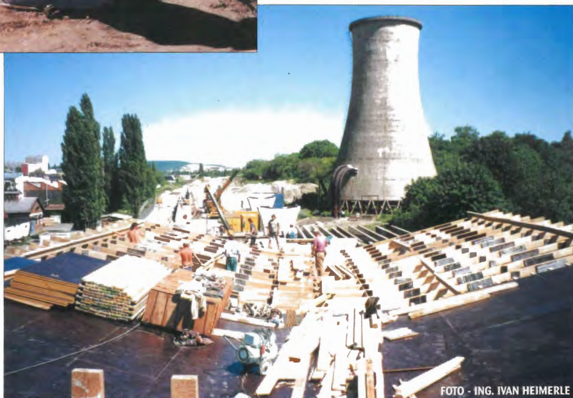
BEDNĚNÍ A BETONOVÁNÍ NOSNÉ KONSTRUKCE MOSTU. REALIZACE - DOPRAVNÍ STAVBY HOLDING, a.s.
