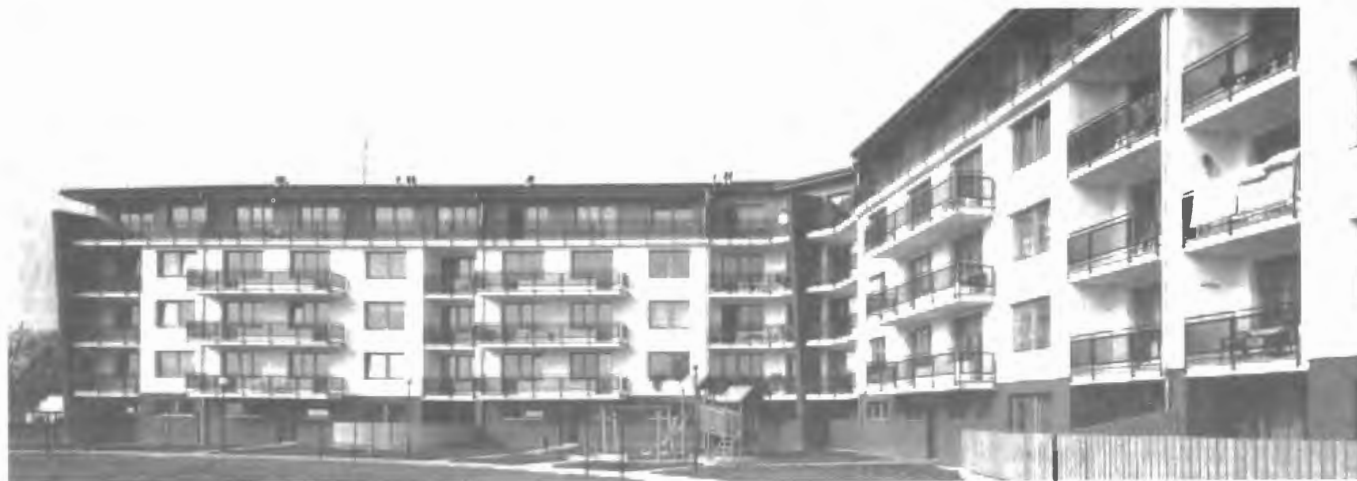
Presta jižní Čechy - 47 bytových jednotek Zliv
