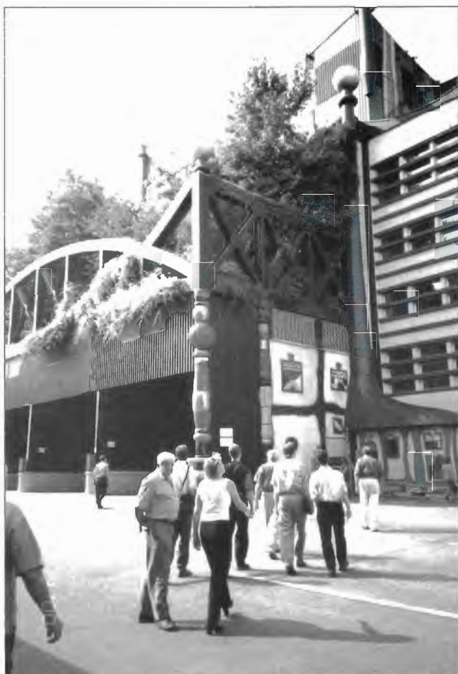
Členění fasády spalovny Spittelau ve Vídni poskytuje díky autorovi panu Hundertwasserovi řadu překvapení
