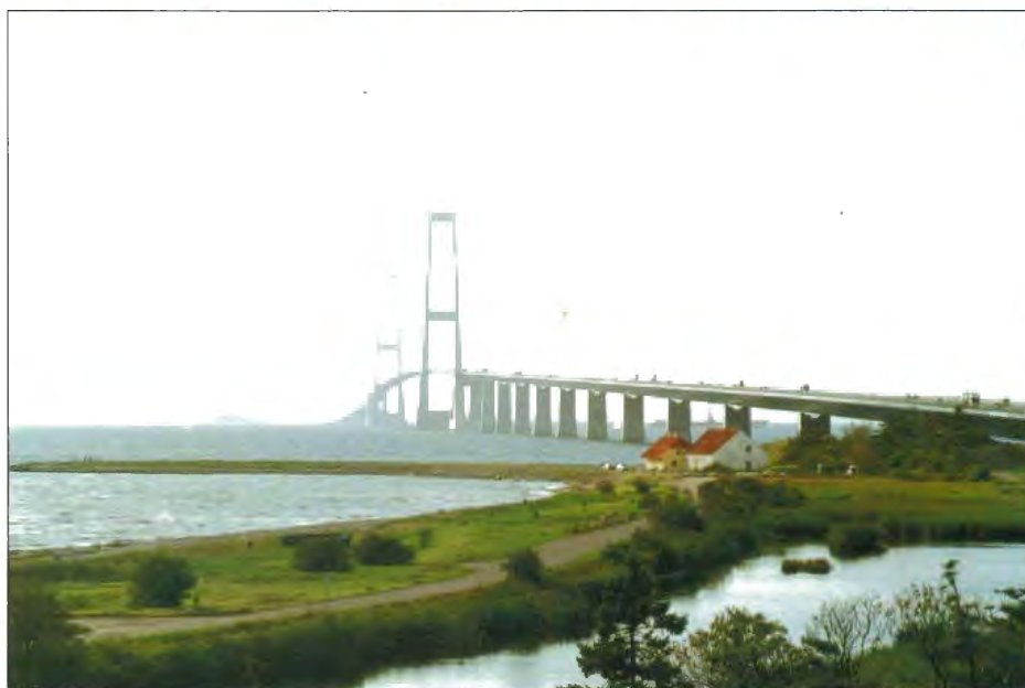
Jedinečný most přes Velký Belt z Nyborgu v Dánsku do Malmö ve Švédsku je v plném provozu. V době výstavby byl cílem exkurzí našich členů.
