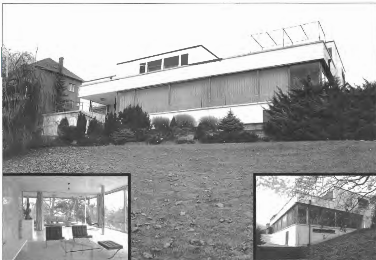
vítěz kategorie bytové stavby – Vila Tugendhat (foto: J. Krejčí) ▼
