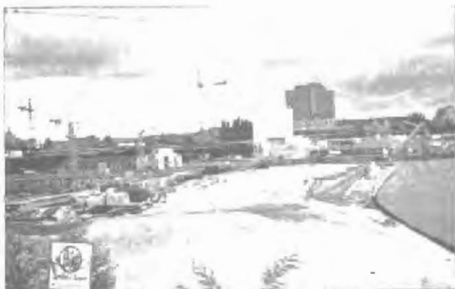
Staveniště Lehrter Bahnhof v Berlíně.
