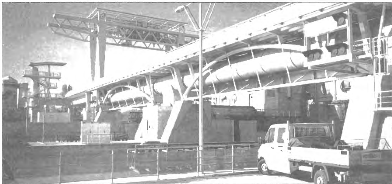
Část vodního díla Freudenau, pohled od elektrárny k plavebním komorám
