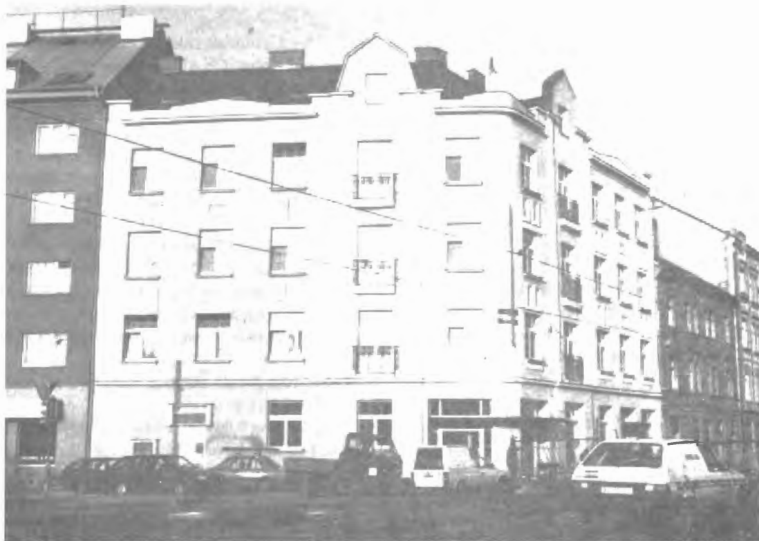
Rekonstrukce domu v Sokolovské ulici v Praze
