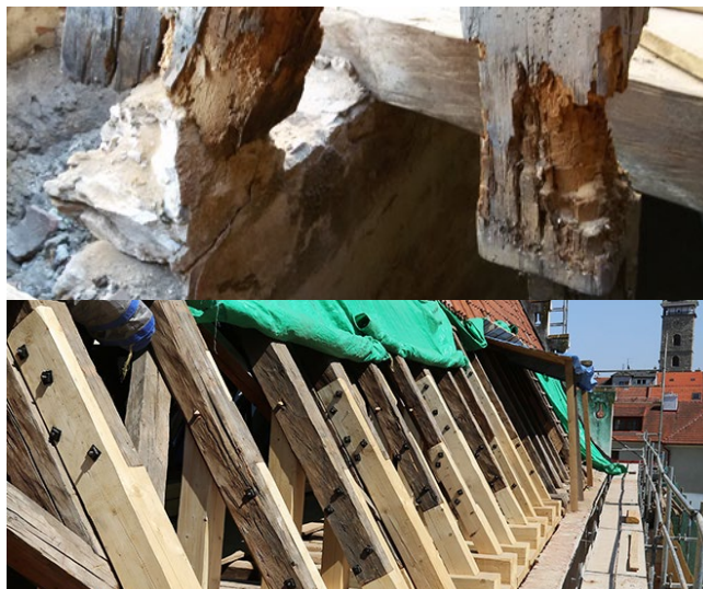
Silně poničený historický krov Solnice v Českých Budějovicích se podařilo úspěšně opravit.
