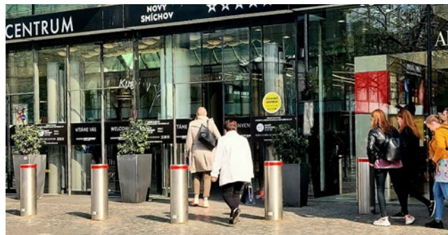
Bezpečnostní prvky (sloupky) k zajištění ochrany před proniknutím jedoucího vozidla do prostoru obchodního centra. Foto: archiv autorky, 2022
