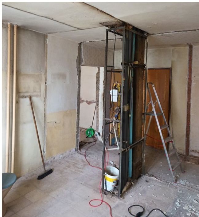
Při rekonstrukcích bytových jader je vhodné statické posouzení stropního panelu. Foto: Ing. Luděk Vejvara, Ph.D.
