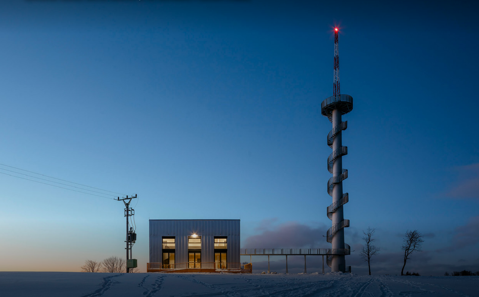
Konverse tubusu větrné elektrárny na rozhlednu v Novém Hrádku
