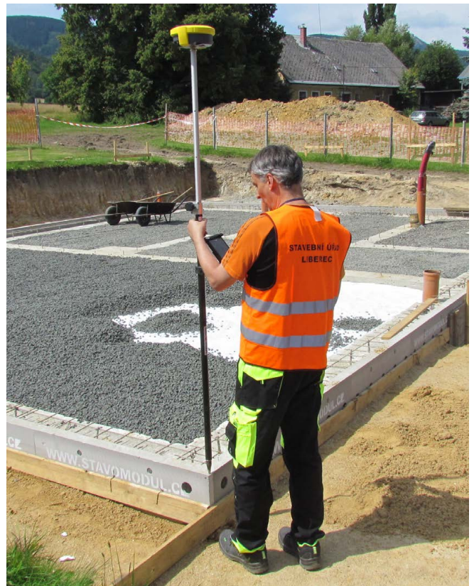
Od letošního léta jsme v Liberci schopni ověřit polohu stavby ve fázi základové desky nejenom „papírově“, ale pomocí geodetického zařízení přímo v souřadnicích GPS satelitním zařízením, se kterým dnes pracují geodeti při vytyčování a zaměřování staveb. To znamená, že s přesností až na centimetry zaměříme základy i na pusté louce či v hlubokém lese a velmi rychle zjistíme případné rozpory s povolením stavby.
