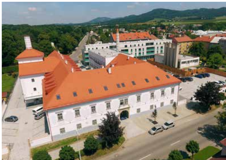
Obnova panského pivovaru Holešov.
