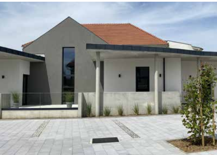
Přístavba kulturního domu Beseda, Nivnice.
