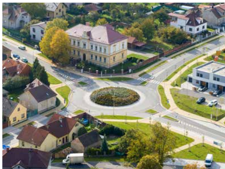
Rekonstrukce Dlážděné ulice v Plzni-Radobyčicích
