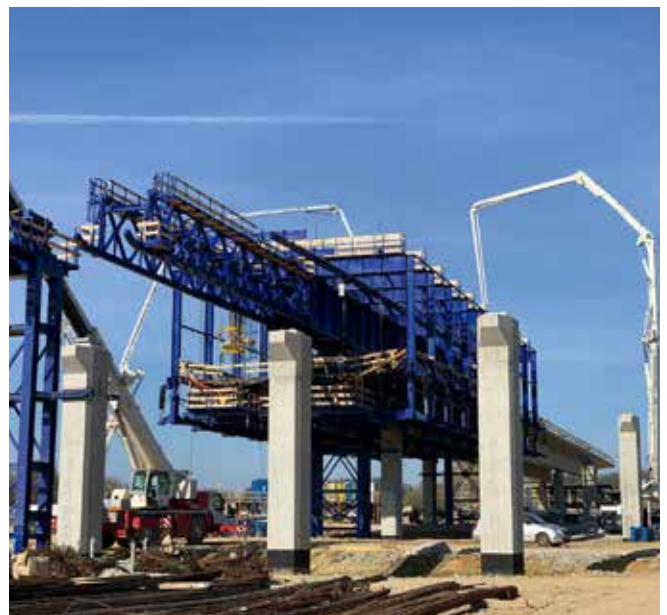
Dálniční most přes údolí řeky Malše (foto: Oblast České Budějovice)
