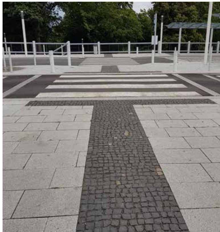
Materiálové složení hmatových úprav signálních a varovných pásů z běžných dlažebních kostek zcela neodpovídá a je v rozporu se zákonnými požadavky.
