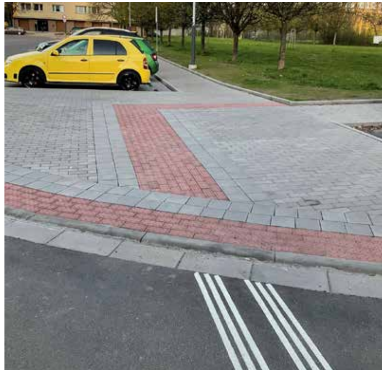
Příklad uplatnění požadavku technického návodu TN TZÚS 12.03.04 na tvarové řešení a lemování hmatové úpravy dlažbou 200 x 200 mm ve dvou řadách tak, aby dlažba se sraženou hranou nebyla v přímé návaznosti na hmatové prvky.
