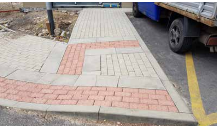
Ukázka provedení hmatového kontrastu rovinnou dlažbou u dlažebních prvků bez zkosené hrany podle požadavků uvedených v technických návodech TN TZÚS 12.03.04. Vlastní princip hmatového vedení je špatně proveden.
