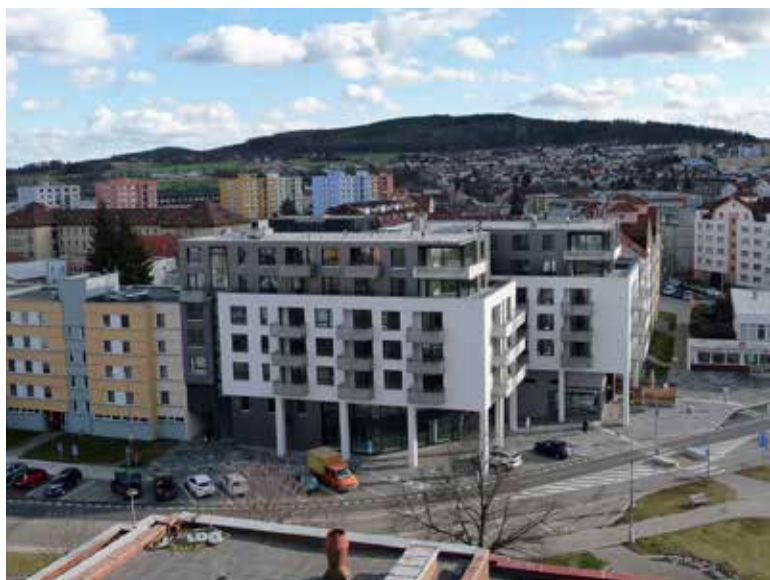
Polyfunkční dům Na Ohradě ve Strakonici (zdroj: PRESTA JIŽNÍ ČECHY)
