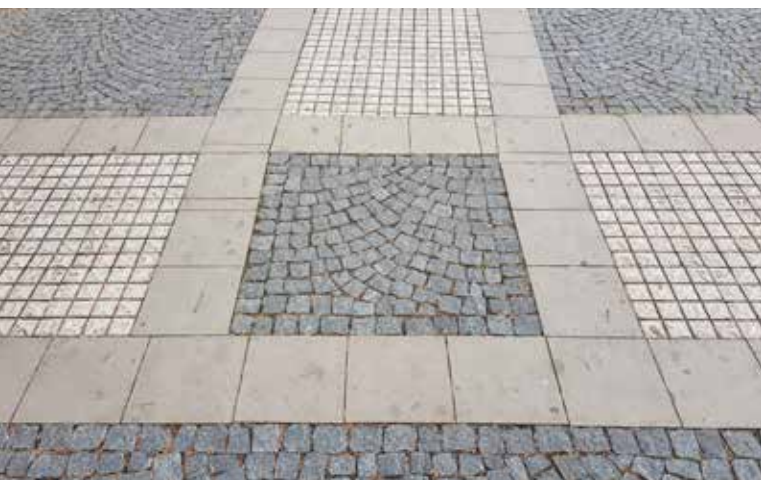
Provedení hmatových úprav signálních pásů z certifikované dlažby s reliéfním povrchem v souladu s požadavky na tvarové řešení a lemování rovinnou dlažbou pro dosažení hmatového kontrastu.
