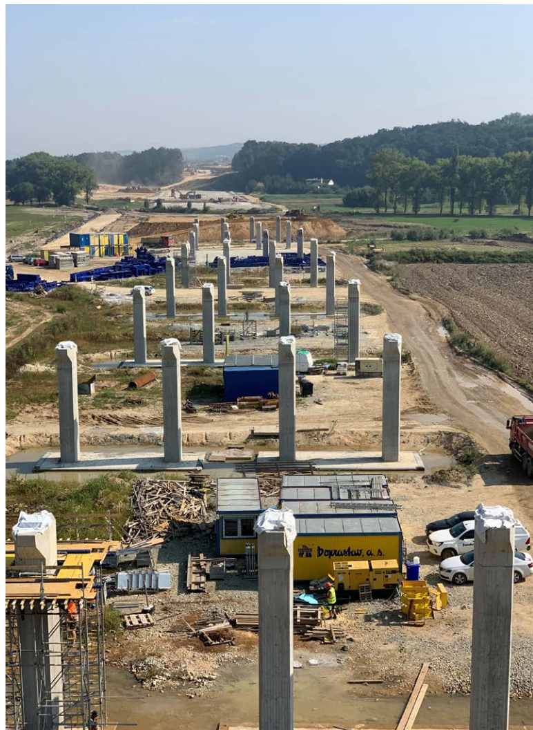
Zemní práce a zakládání mostů od Českých Budějovic k Třebonínu (foto: oblast ČKAIT České Budějovice)
