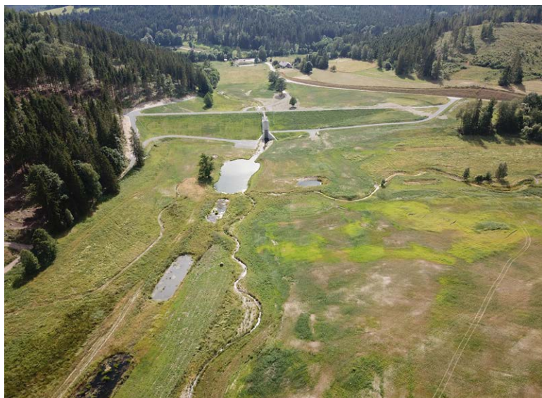
Suchá nádrž Jelení, Karlovice – hlavní cena v kategorii Stavby dopravní, inženýrské a vodohospodářské (foto: OHL ŽS, a.s.)
